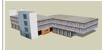
Gebäude 2 der Hochschule
